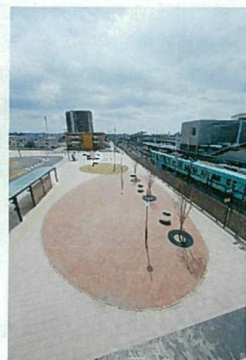
東口駅前広場。近隣を流れる矢野川の石をベンチに活用した。線路沿いに設けた面積約500㎡のイベント用空間では、供用開始後に市民による駅前ヨガなどが開催された
